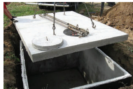
Montaż szamb bezodpływowych
