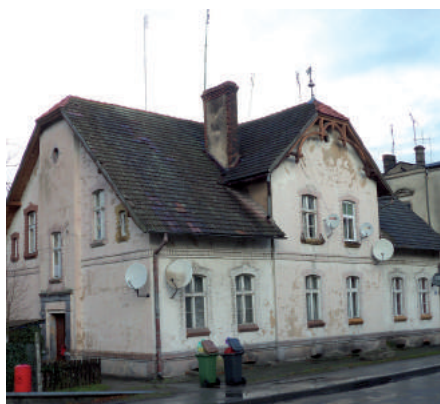
Budynek przy ul. Staszica 5 w Wieleniu przed remontem
