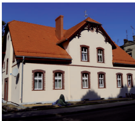
Budynek przy ul. Staszica 5 w Wieleniu po remoncie
