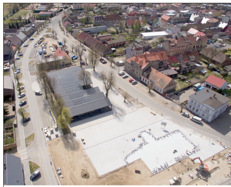
Widok z drona na ul. Nowe Miasto w Wieleniu w trakcie prac rewitalizacyjnych
